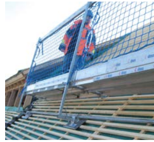
Fig. 4 Garde-corps intermédiaire de classe C.
