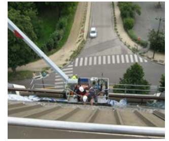
Fig. 5 Utilisation de PEMP pour une pente supérieure à 60°.
